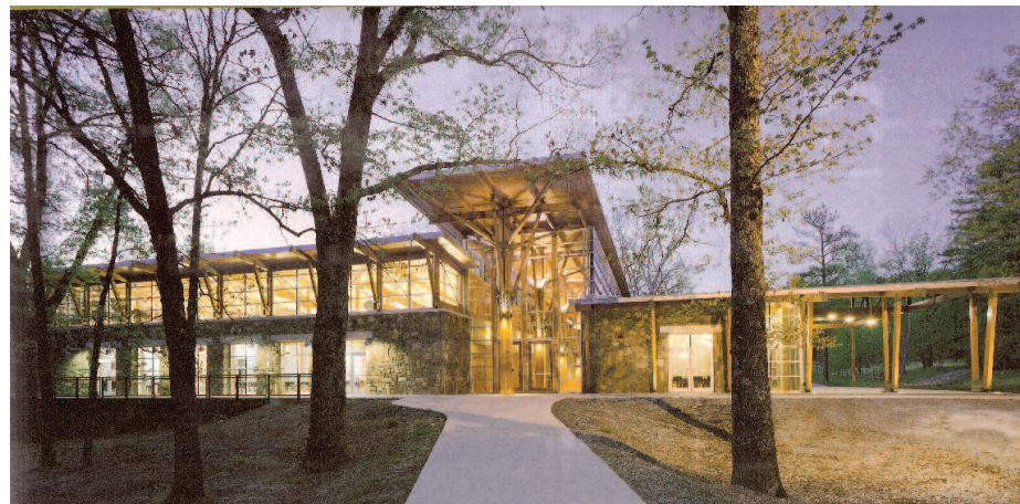
Camp Aldersgate Commons Binası, Arkansas, Wilcox Group Architects, LEED Gold sertifikalı.
